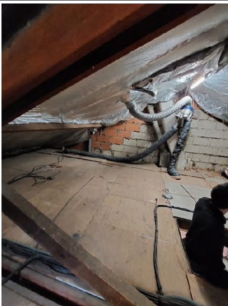
Couverture tuiles sur charpente bois traditionnelle isolée
